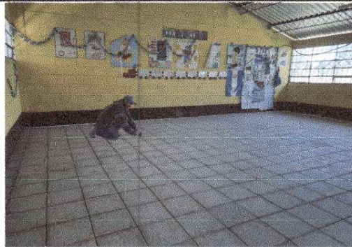
Foto 6: Sustitución de piso de torta de concreto por piso de granito
