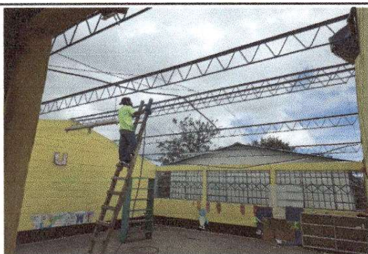
Foto 3: Mantenimiento a estructura de soporte de metal
