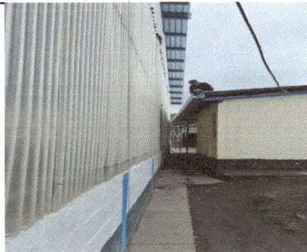
Foto 4: Sustitución de canal de pvc
