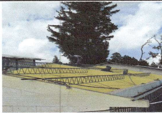
Foto 2: Sustitución de capote de lámina para lámina troquelada
