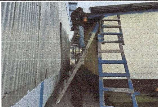
Foto 5: Reparación de bajada de agua plubial, tubo PVC 4"
