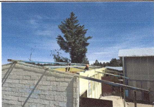
Foto 1: Sustitución de lámina, por lámina troquelada aluzinc calibre 26
